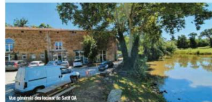
Vue générale des locaux de Satif OA
