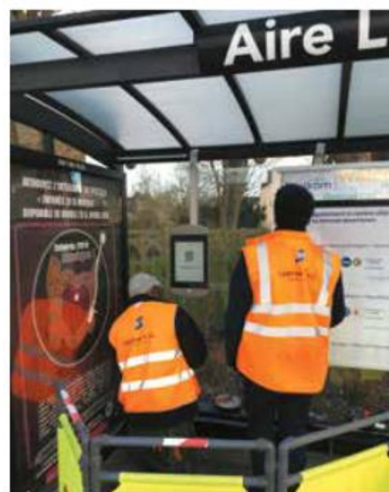
Installation d'une BIV E-Paper® dans un abribus à Rennes. À ce jour, SERFIM T.I.C a installé une soixantaine d'écrans pour les réseaux de transports.
